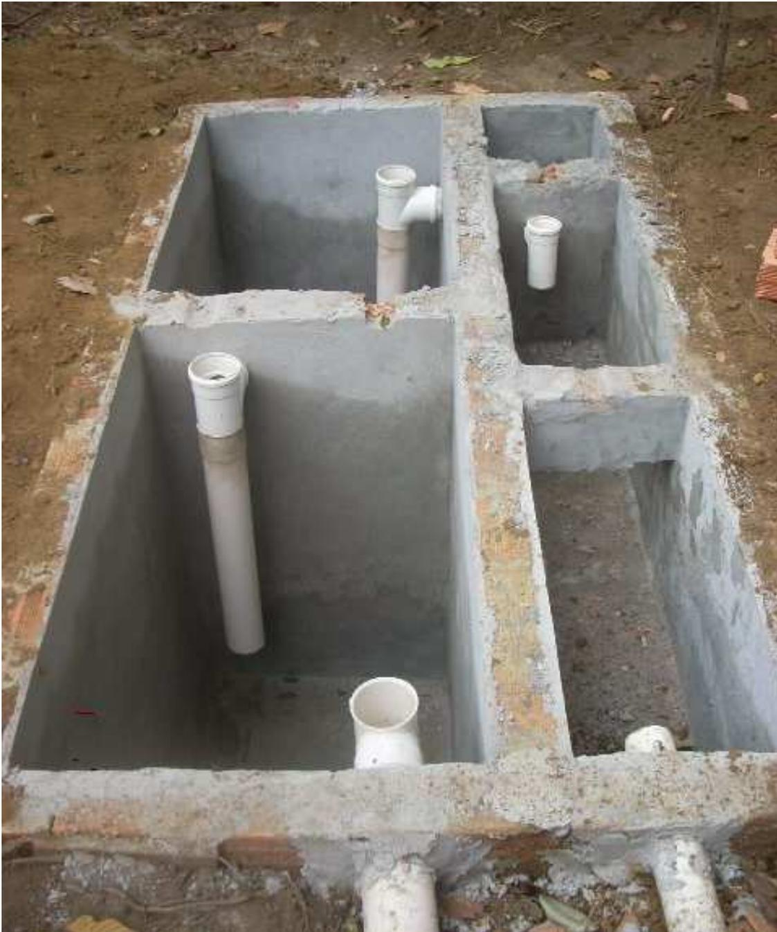
Figura 13. Conjunto de reator anaeróbio, decantador e caixa de mistura dos efluentes. Fonte: <http://bioarquitekturapaisagem.blogspot.com.br>
