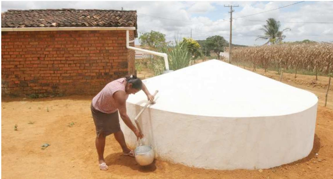
**Figura 10. Exemplo de cisterna instalada em unidade familiar individual como método de abastecimento. Fonte: [www.ebc.com.br](http://www.ebc.com.br)**
